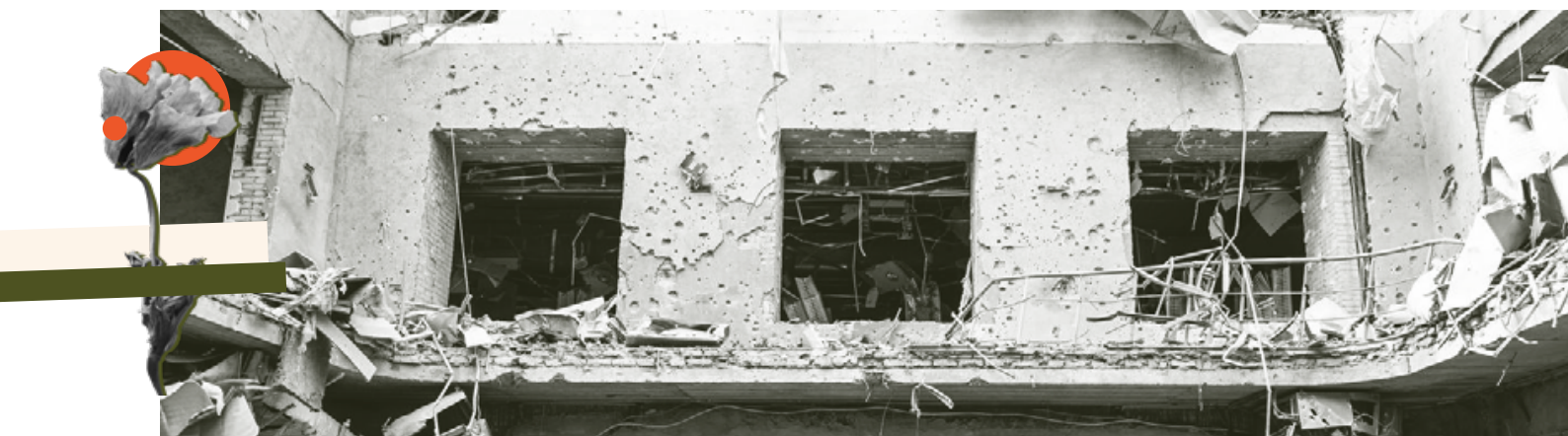
Фото: «Кордон медіа». Конгрес-центр Сумського державного університету — колишній осередок журналістських заходів Сумщини. Будівля постраждала внаслідок російського обстрілу.
